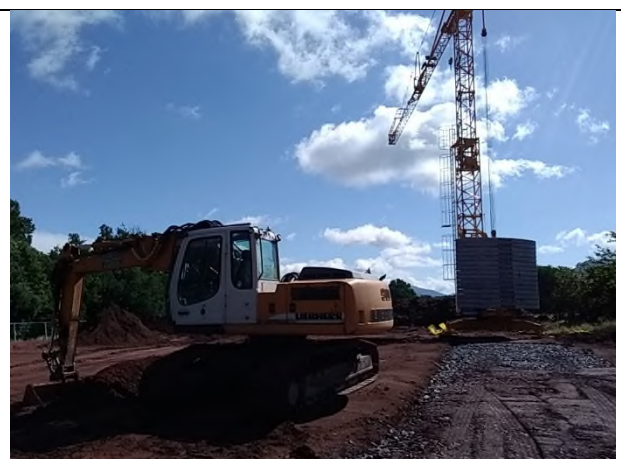
Terrassement et grue à tour montée
