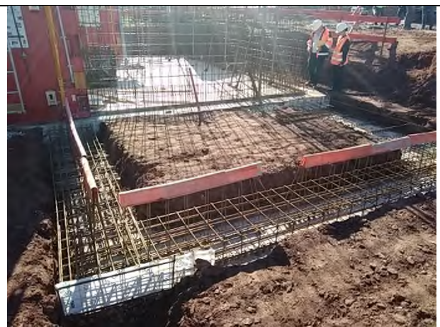
Fondation des locaux (surpresseur et électrique)
