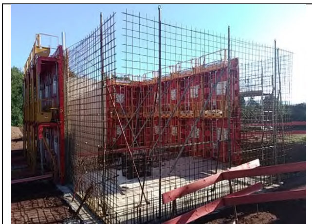
Ferrailage en cours des voiles des cellules SBR
