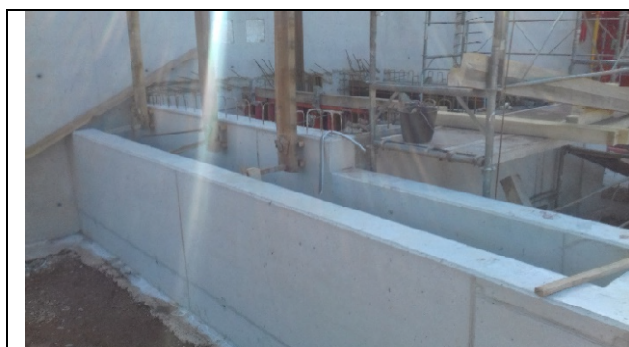
Canal de comptage bétonné
