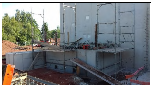
Voiles des baches eaux industrielles, bac à graisses et bac à sable en cours de réalisation
