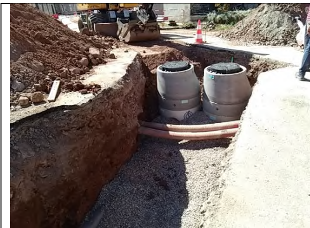
Réseau posé et croisement avec la conduite AEP
