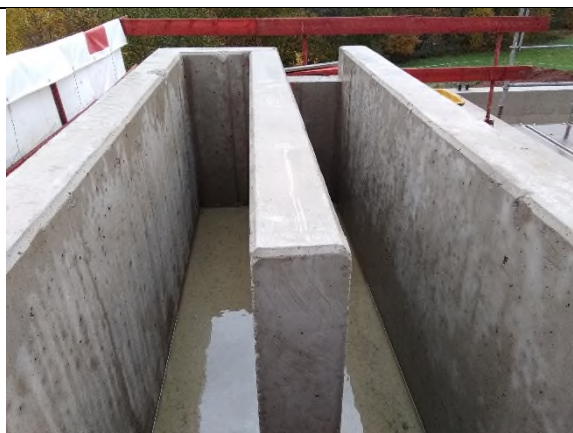
Canal du dégrilleur décoffré
