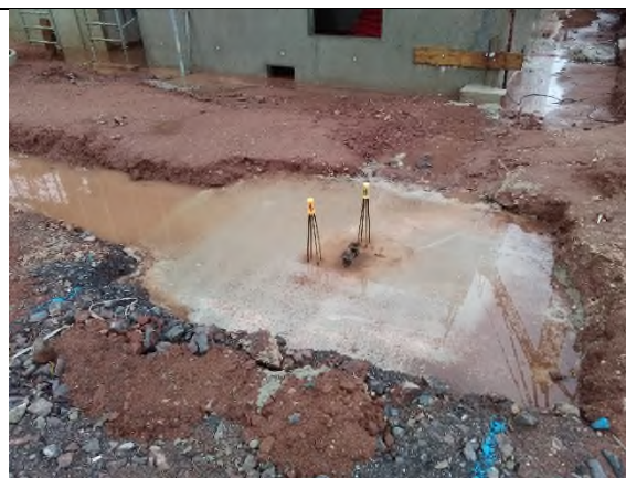
Massifs de fondation pour les poteaux (structure métallique) coulés
