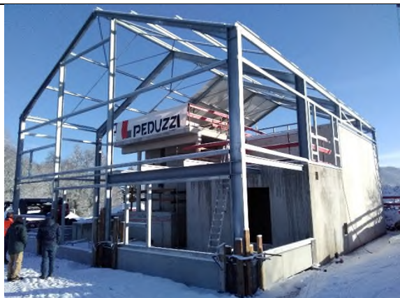
Charpente et longrines posées
