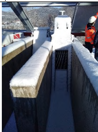
Dégrilleur/compacteur installé
