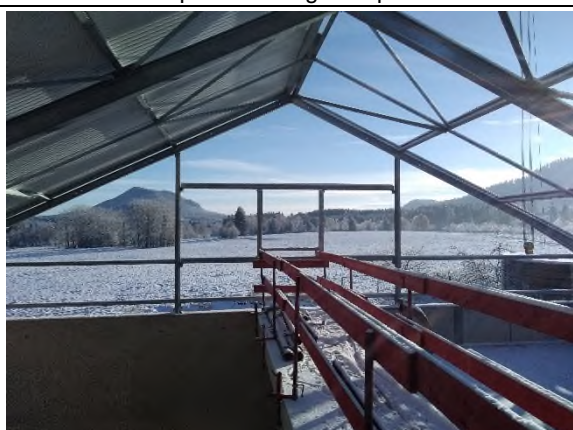
Couverture en cours de pose
