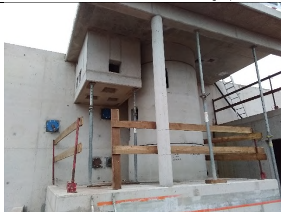
Regard de répartition et DDC réalisés
