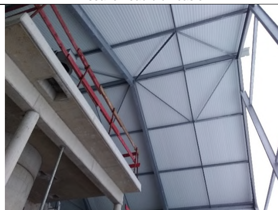
Pose de la couverture terminée
