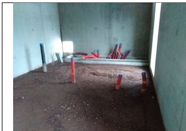
Réseaux intérieurs et remblaiement terminés
