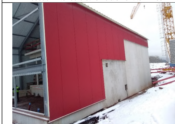
Bardage en cours de pose
