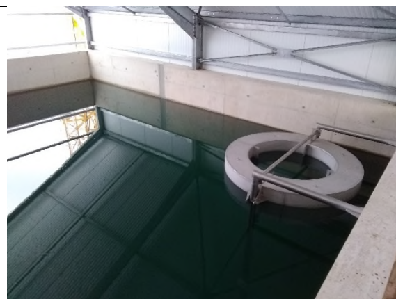
Essai en eau d'un casier
