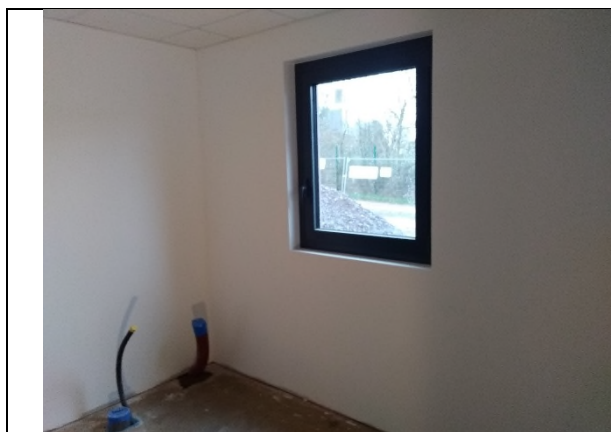
Second œuvre des locaux techniques
