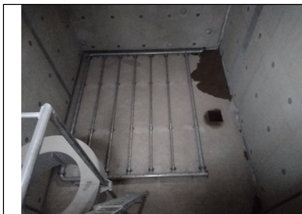
Les rampes d'aération dans un casier posées
