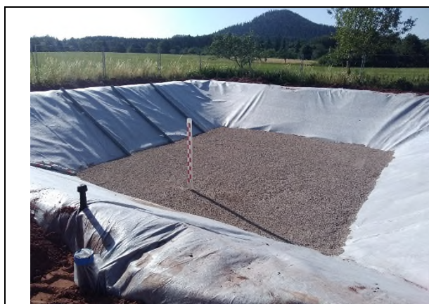
Lits de séchage en cours de réalisation
